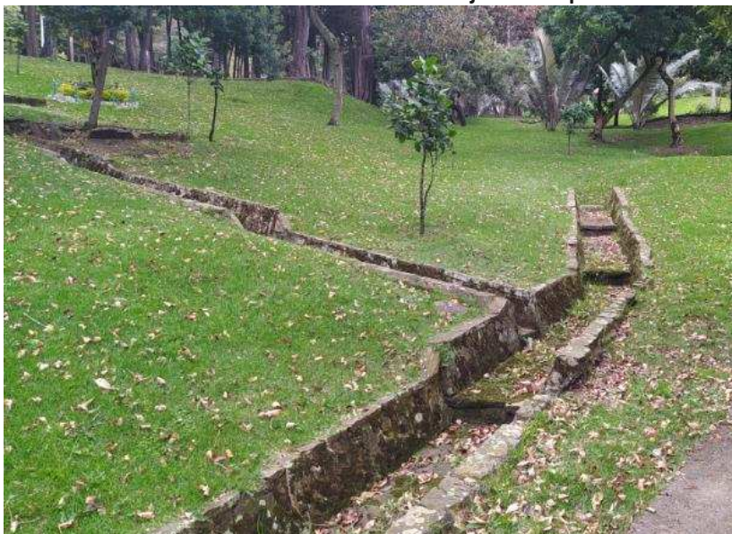
Imagen 53. Estado actual de la zona 1 de la propuesta de construcción y rehabilitación del sistema interno de drenaje del Parque Nacional.
