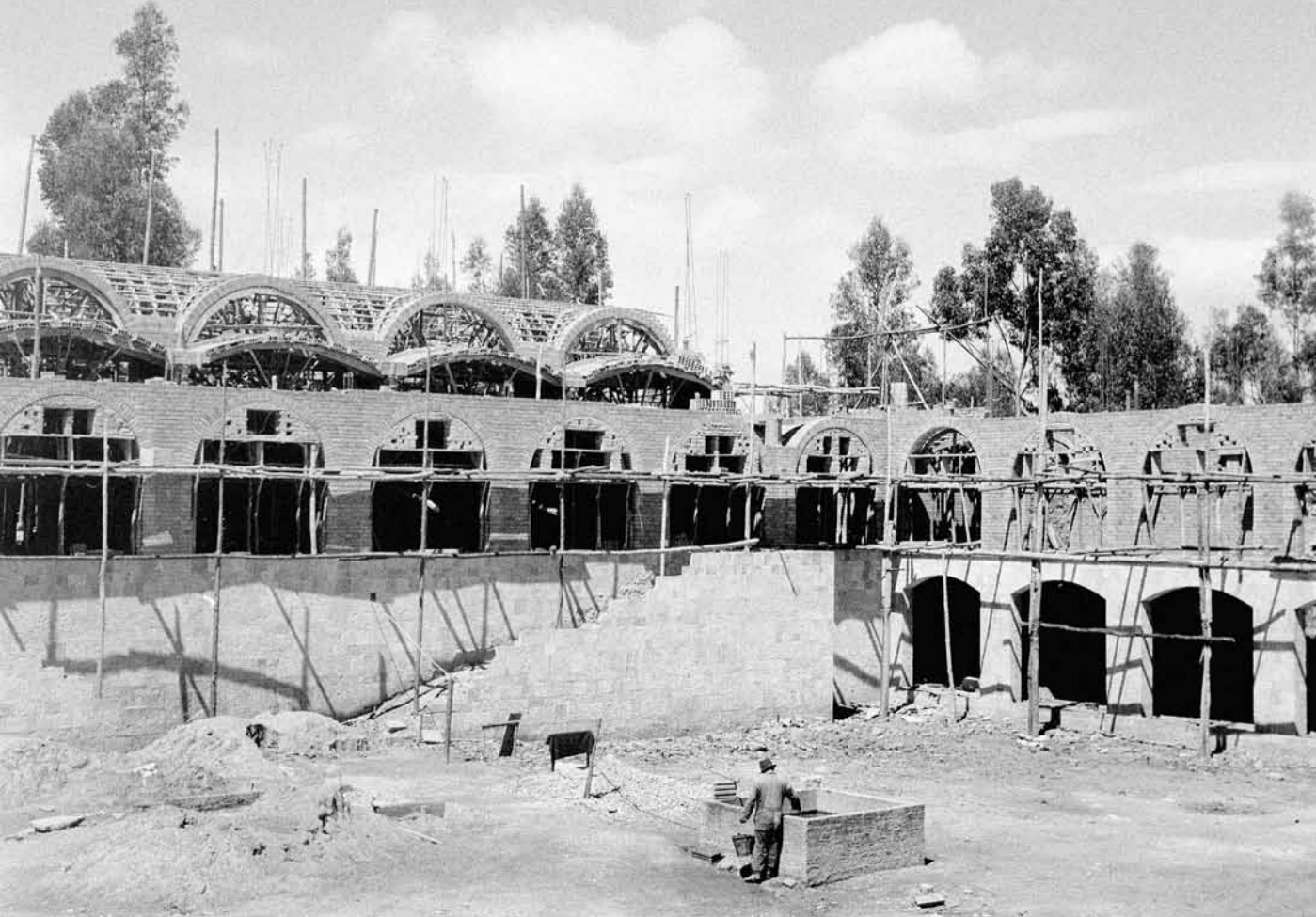
→ Obra de las bóvedas de segunda planta del Convento de Santo Domingo. Se destaca el trabajo de formaletería y andamiaje. Colección María Teresa Montoya de Barriga.
