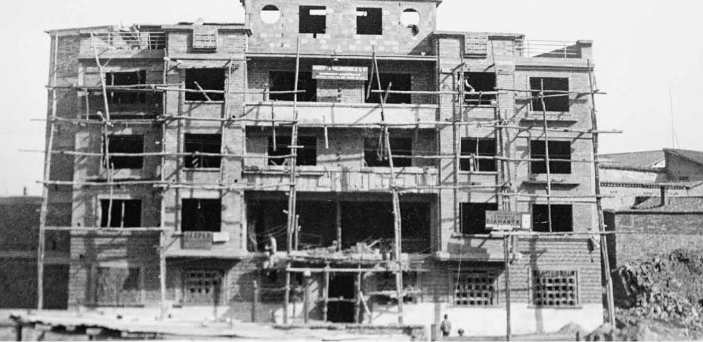
→ Proceso constructivo del edificio de renta diseñado por Jose María Montoya Valenzuela para el señor Manuel Castello en 1936. Fue el primero en altura construido en la Avenida Jiménez entre carreras 1a y 6a. Demolido hacia 1950. Colección María Teresa Montoya de Barriga.
