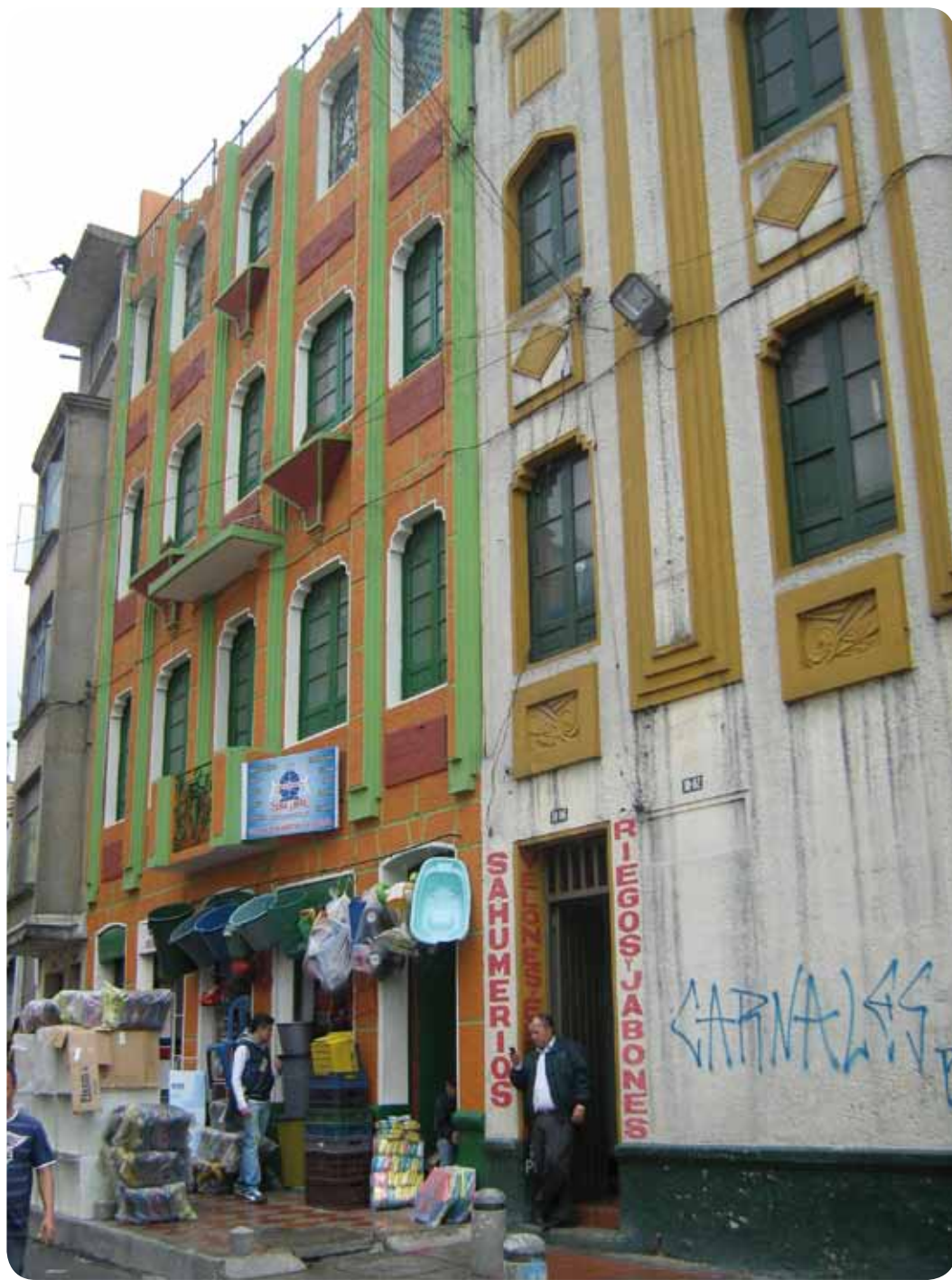
Rezagos del Cartucho. Construcciones republicanas originales de la zona entre San Victorino y el barrio Santa Inés alrededor del hoy parque Tercer Milenio. [ Ingrid Morris Rincón, 2009]
