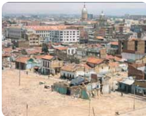
Primeras demoliciones. Empresa de renovación Urbana, 1999 [ Archivo Personal Arquitecto Camilo Santa María ]
