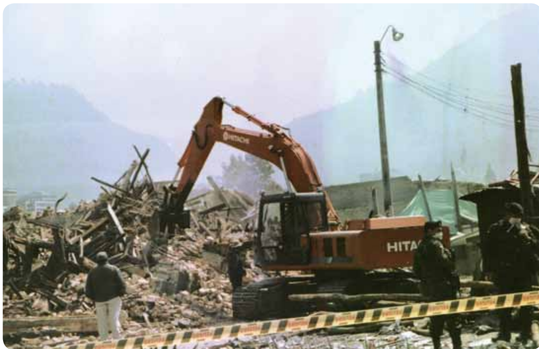
Proceso de demolición del barrio Santa Inés – El Cartucho
