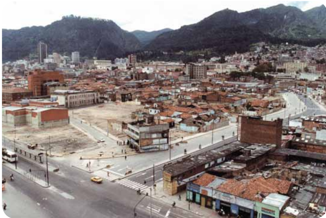
Demolición vista hacia el occidente. Empresa de renovación Urbana, 2000 [ Archivo Personal Arquitecto Camilo Santa María ]
