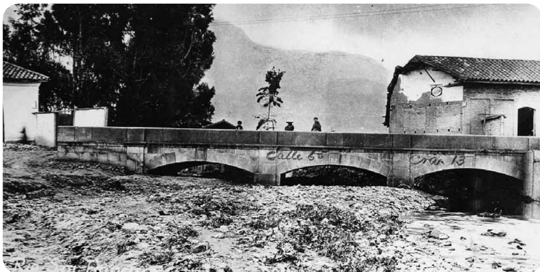
Puente Uribe. Situado en el cruce de la carera 13 con la calle 6, donde conflúan los ríos San Francisco y San Agustín. Se colocó la primera piedra el 1° de mayo de 1892. Foto anónima.
