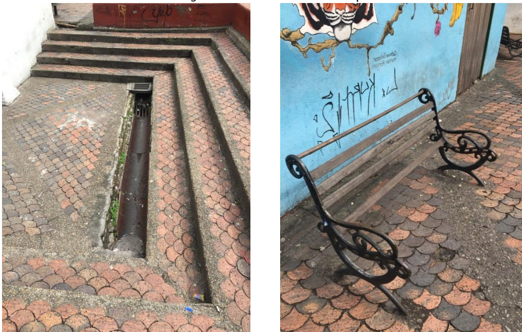
Figura 25. Estado actual de la plazoleta
