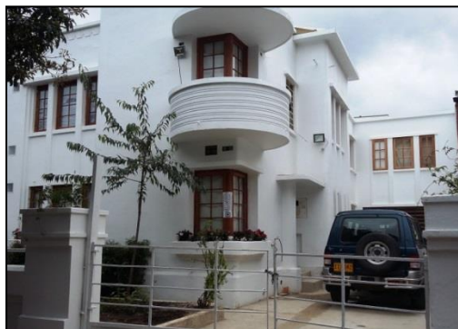
Imagen: Fachada inmueble Carrera 16 No 39-53, sello emitido por la Alcaldía local frente a las infracciones urbanísticas cometidas en este inmueble. Fuente: archivo digital IDPC
