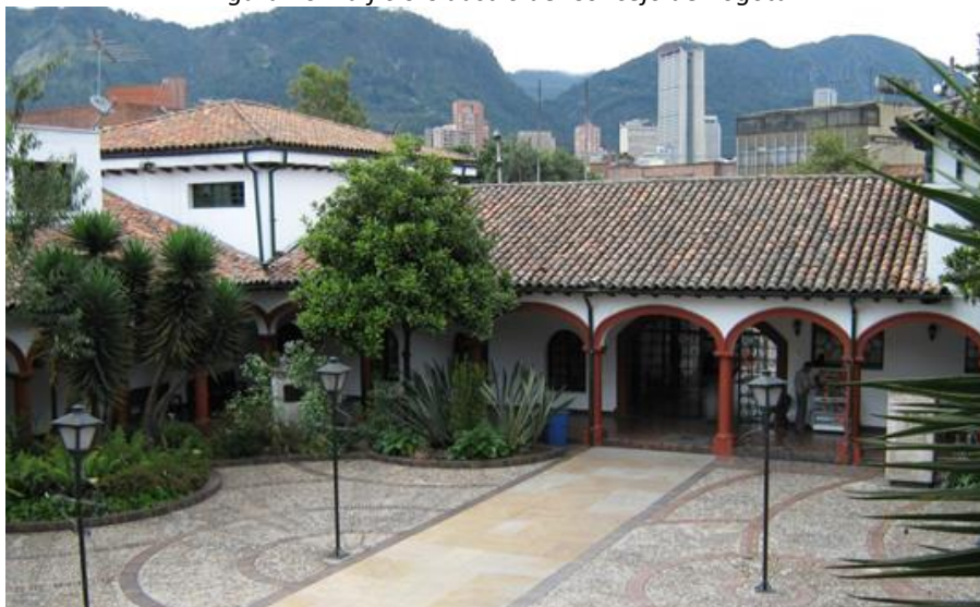
Figura 26. Edificio Claustro del Concejo de Bogotá
