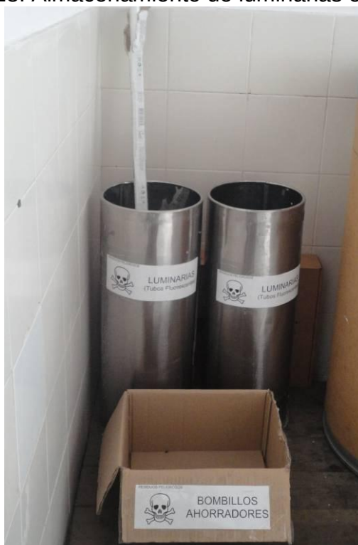
Imagen 18. Almacenamiento de luminarias en el IDPC
