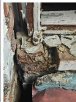
Ilustración 7. Afectación NO continuidad de muros. Fuente: construcción propia
