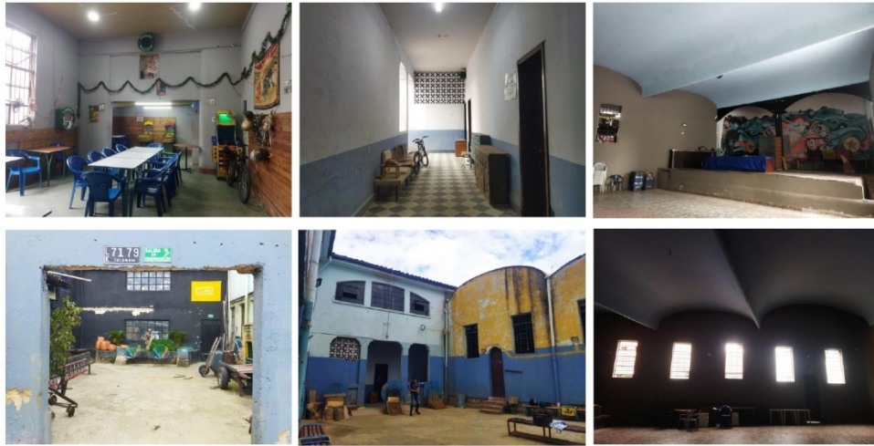
Registro fotográfico primer piso Fuente: Valoración e inventario IDPC, Junio 2025
