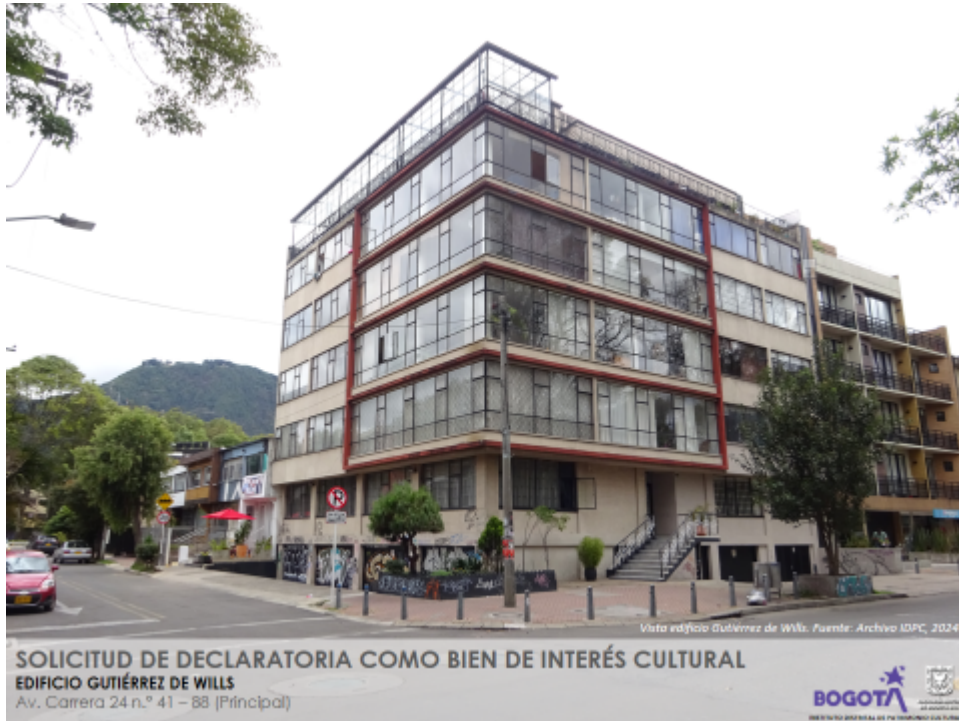
Imagen 7. Solicitud de declaratoria como bien de interés cultural del edificio Gutiérrez de Wills, ubicado en la Av. Carrera 24 n.º 41 – 88/ 78/ 82/ 86 y/o Calle 42 n.º 22 51/ 55/ 61/ 65. Fuente: presentación del IDPC.
