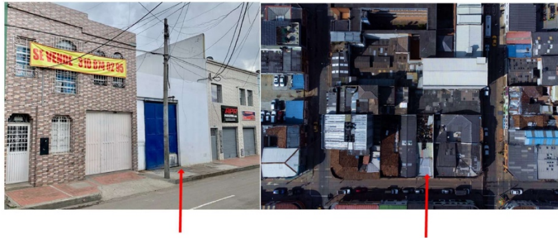
Imagen 82. Recurso de reposición interpuesto en contra de la Resolución SCRD 95 de 2025 - Revocatoria de la condición patrimonial del inmueble ubicado en la Calle 12B n.º 22 - 33/37. Fuente: presentación de los solicitantes
