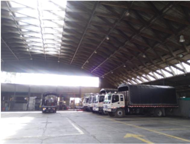
El Gigante de Bogotá, se destaca por su nivel de conservación, a pesar de que no se le hecho ningún tipo de mantenimiento y su estructura de **junturas metálicas** que se entrecruzan en el **costillar que soporta su estructura**, las paredes de **duraluminio** del color verdoso grisáceo original para protegerlo adecuadamente de las condiciones abrasivas del clima, los **vidrios importados** que han soportado temblores y granizadas.
