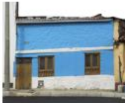
Fachada inmueble Fuente: PEMP Centro Histórico de Bogotá - SGTDP
