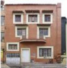
KR 14 A 40 A 68 (Para el año 2007 se reemplaza la cubierta original por teja de fibrocemento en un 25% y el vacío posterior esquinero está totalmente cubierto. En el 2009, el costado norte del predio se encuentra totalmente cubierto en una materialidad distinta a la original. Para el 2017, todo el predio tiene una cubierta plana con una adición de un tercer piso, perdiendo tanto la tipología como la volumetría original. No se conocen datos de solicitudes de intervención.)
