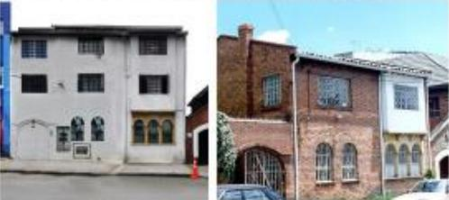
CL 33 A 14 19 Para el 2009 se observa un cambio en el acabado de cubierta de ambos volúmenes, así como la construcción de un tercer nivel y los vacíos posteriores cubiertos en un 100%. En el 2021 se evidencia el aislamiento lateral cubierto en un 100% y la construcción de un cuarto nivel retrocedido respecto a la línea de fachada. No se encontraron solicitudes de licencia.
