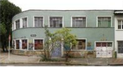
KR 14 A 40 A 59 Para 1998 se evidencia el cubrimiento total del vacío lateral. Para el año 2009 se evidencia el reemplazo total del acabado de cubierta, de teja de barro a teja de fibrocemento y la permanencia del cubrimiento total del vacío lateral, a la fecha no es posible determinar si la cubierta actual es inclinada o plana.
