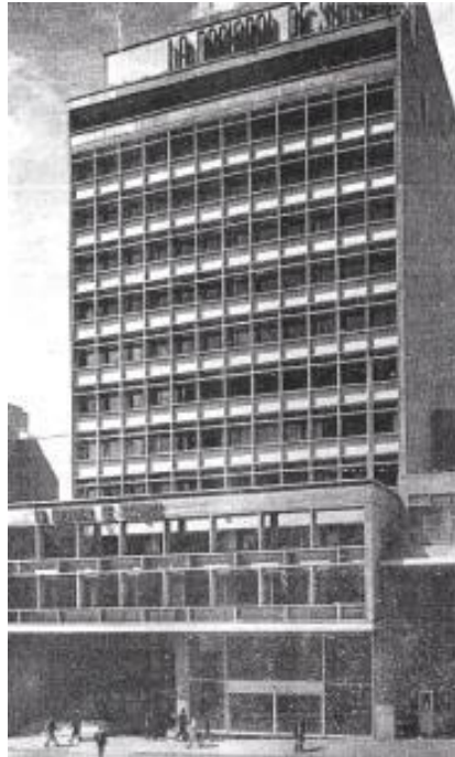
Imagen 4. Fotografía del edificio recién construido. Fuente: Proa No. 126
