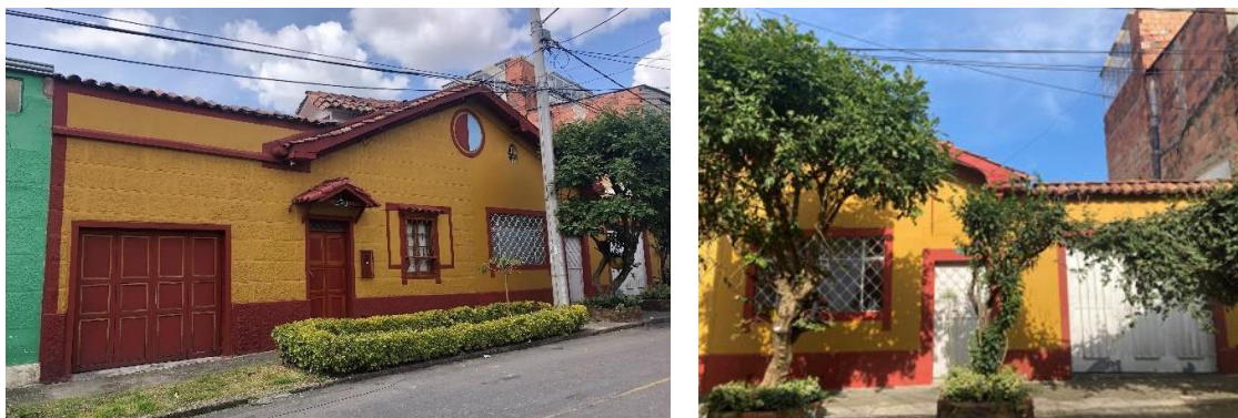
Imagen 7. Estado Actual, Fachadas. Fuente: Acta de visita IDPC – SCRD, noviembre -2022.
