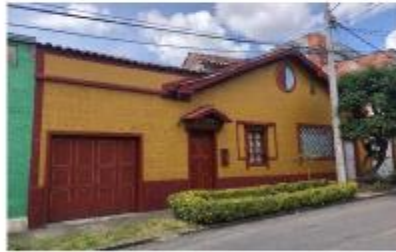
Estado Actual, Fachada. Fuente: Acto de vista IDPC - SORD, noviembre -2022
