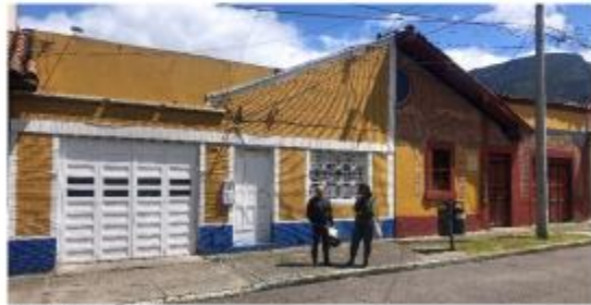
Estado Actual, Fachada. Fuente: Acto de visita IDPC - SCRD, noviembre - 2022
