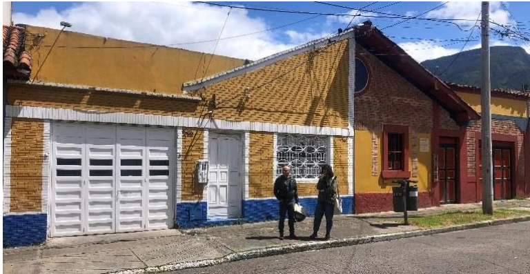
Imagen 5. Estado Actual, Fachada. Fuente: Acta de visita IDPC – SCR D, noviembre -2022.
