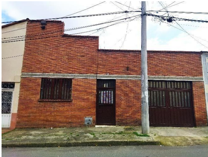
Imagen 6. Estado Actual, Fachada. Fuente: Acta de visita IDPC – SCR D, noviembre -2022.
