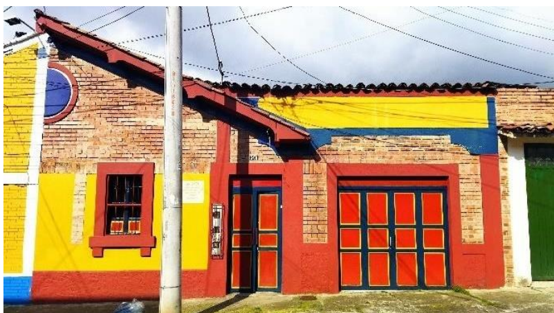
Imagen 4. Estado Actual, Fachada. Fuente: Acta de visita IDPC – SCR D, noviembre -2022.
