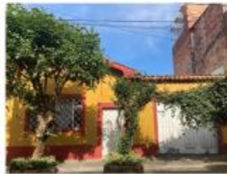
Estado Actual, Fachada. Fuente: Acto de vista IDPC - SORD, noviembre -2022
