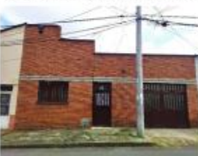
Estado Actual, Fachada. Fuente: Acto de visita IDPC - SCRD, noviembre - 2022
