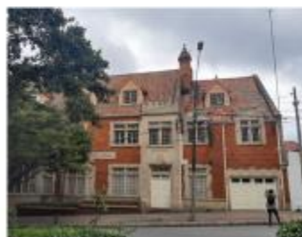
Fachada de inmueble. Fuente: Archivo IDPC, 2022
