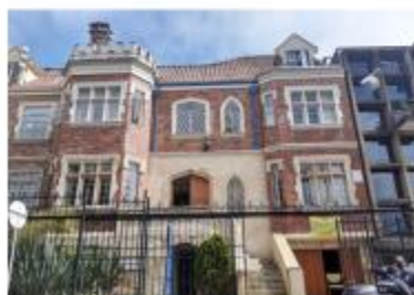
Fachada de inmueble. Fuente: Archivo IDPC, 2022
