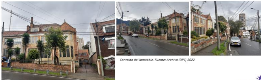
Fachada de inmueble. Fuente: Archivo IDPC, 2022
