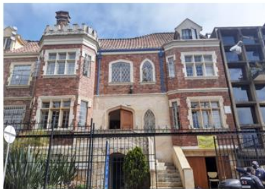
Fachada de inmueble. Fuente: Archivo IDPC, 2022
