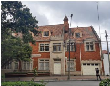
Fachada de inmueble. Fuente: Archivo IDPC, 2022
