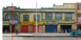
Fachada. Fuente: Ficha de Valoración Individual, 2021.
