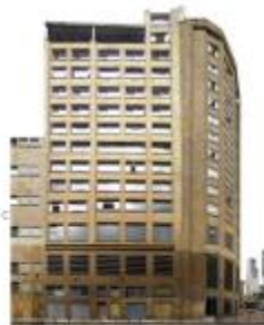
Fachada. Fuente: Ficha de Valoración Individual, 2021.
