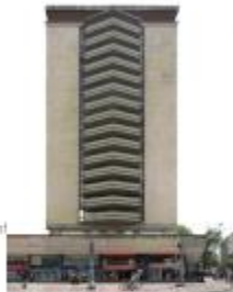
Fachada. Fuente: Ficha de Valoración Individual, 2022.
