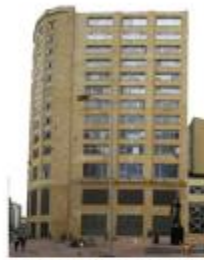
Fachada. Fuente: Ficha de Valoración Individual, 2022.
