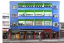
Fachada. Fuente: Ficha de Valoración Individual, 2021.
