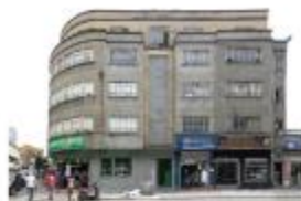
Fachada. Fuente: Ficha de Valoración Individual, 2021.
