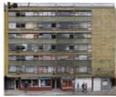
Fachada. Fuente: Ficha de Valoración Individual, 2022.
