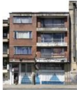
Fachada. Fuente: Ficha de Valoración Individual, 2021.
