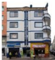
Fachada. Fuente: Ficha de Valoración Individual, 2021.
