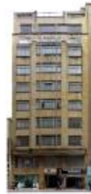
Fachada. Fuente: Ficha de Valoración Individual, 2021
