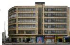
Fachada. Fuente: Ficha de Valoración Individual, 2021.
