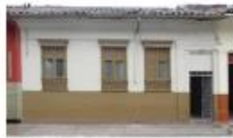
Fachada. Fuente: Ficha de Valoración Individual, 2021.
