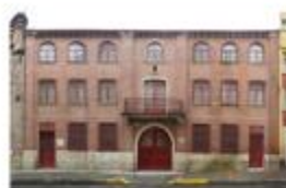
Fachada. Fuente: Fichas de Valoración Individual, 2022.
