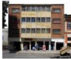
Fachada. Fuente: Ficha de Valoración Individual, 2022.
