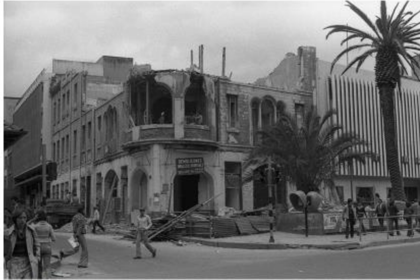
Demolición del antiguo edificio Terraza Pasteur 1979. Fondo Jorge Silva, Archivo de Bogotá.
