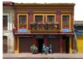
Fachada. Fuente: Ficha de Valoración Individual, 2022.
