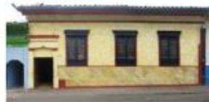
Fachada. Fuente: Fichero de Valoración Individual, 2021.
