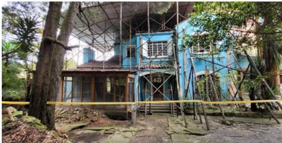
Fachada. Fuente: observatorio aportado por el solicitante 2023.
