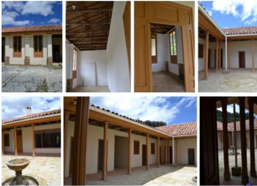
Patio central. Informe técnico de visita SORD e IDPC, 2022.
