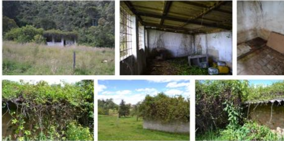
Construcción en predio declarado BIC (CHIP AAA0142K2WF)
