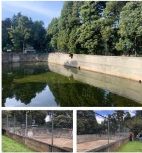
El Tanque Antigo siguió la forma de rectángulo redondeado del tanque construido en los años anteriores: su estructura bajo el nivel del terreno se construyó en mampostería cocida recubierta en concreto. Estos muros de contención son continuos en todo el perímetro del tanque y funcionan como voladizos con una base más ancha que decrece hasta la corona, así logra soportar los empujes del suelo que se hacen más grandes a mayor profundidad.
