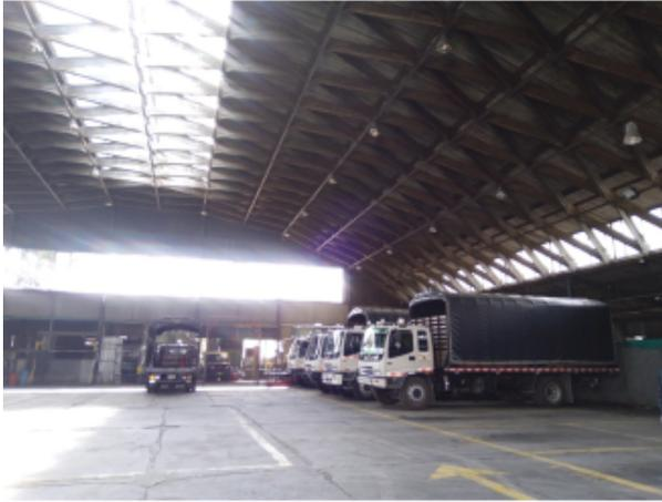
Actualmente se destacan al interior del predio una estructura de **junturas metálicas que se entrecruzan en el costillar que soporta la estructura en su conjunto**, paredes de **duraluminio** del color verdoso grisáceo característico original para protegerlo adecuadamente de las condiciones abrasivas del clima, **vidrios importados** con el conjunto, que cuenta actualmente con alojamientos y cocinetas
