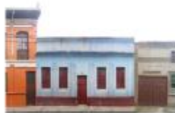
Fachada y perfil. Fuente: Ficha de Valoración individual, PEMP CHB 2021.
