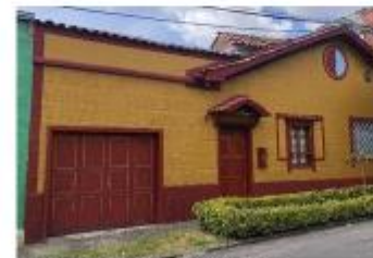
Carrera 4 8 A 23 Sur. Estado actual. Fuente: Acto de visita (DPC - SORD), noviembre -2022
