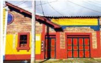
Calle 9 A Sur 5 56. Estado actual. Fuente: Acto de visita (DPC - SORD), noviembre -2022
