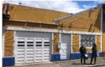
Calle 9 A Sur 5 66. Estado actual. Fuente: Acto de visita (DPC - SORD), noviembre -2022
