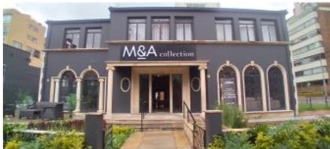
Fachada Sur. Fuente: IDPC 2022.
