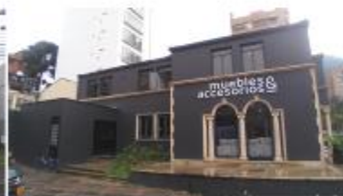
Fachada Occidente. Fuente: IDPC 2022.
