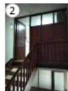
Construcción de mezzanine
