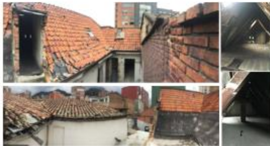
Estado actual de cubiertas.
