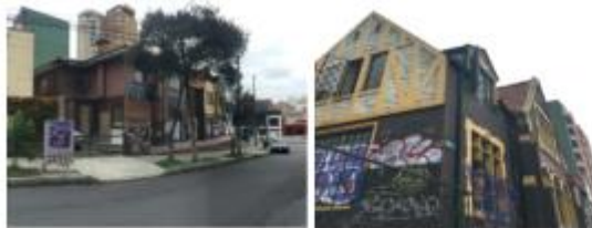
Estado actual de fachadas.
