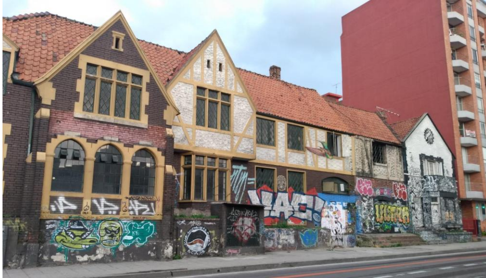
Imagen 1. Inmueble objeto de la solicitud. Fuente: Visita técnica IDPC, 2021.
