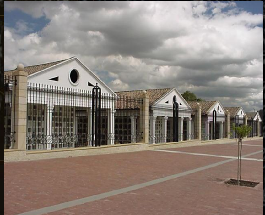
Estado actual del acceso al cementerio sobre las calles
