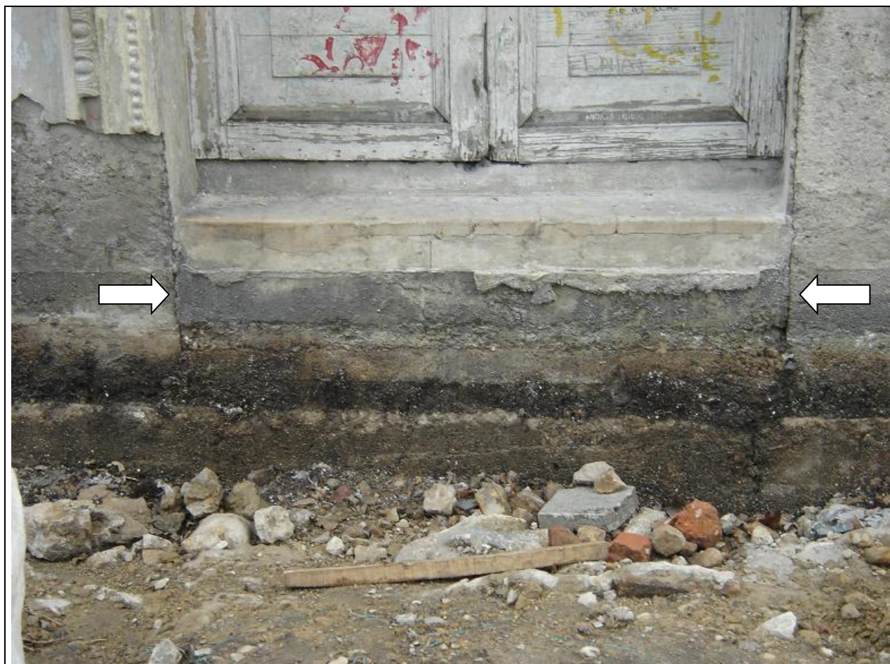
Figura 8. Perfil de la entrada Sur-occidental del Quiosco, después de haber sido removidos los escalones, se observa las huellas del vano que fueron selladas en la parte inferior.
