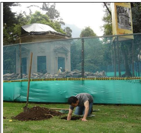
Figura 26 Trabajo en el pozo de sondeo 4
