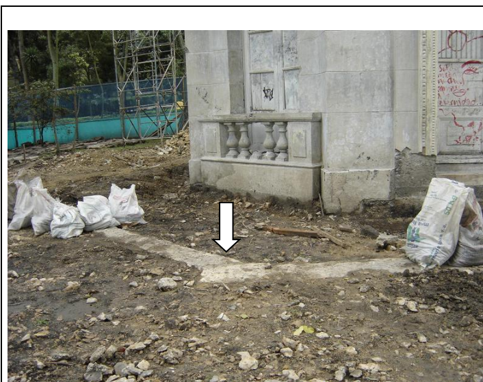
Figura 5. Estructura en Cemento que rodeaba el Quiosco, observar el relleno que existe en el espacio que separa a la estructura de los muros del edificio
