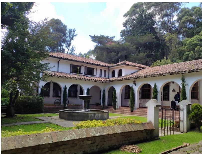
Imagen 1. Inmueble objeto de la solicitud. Fuente: Visita técnica IDPC, 2021.
