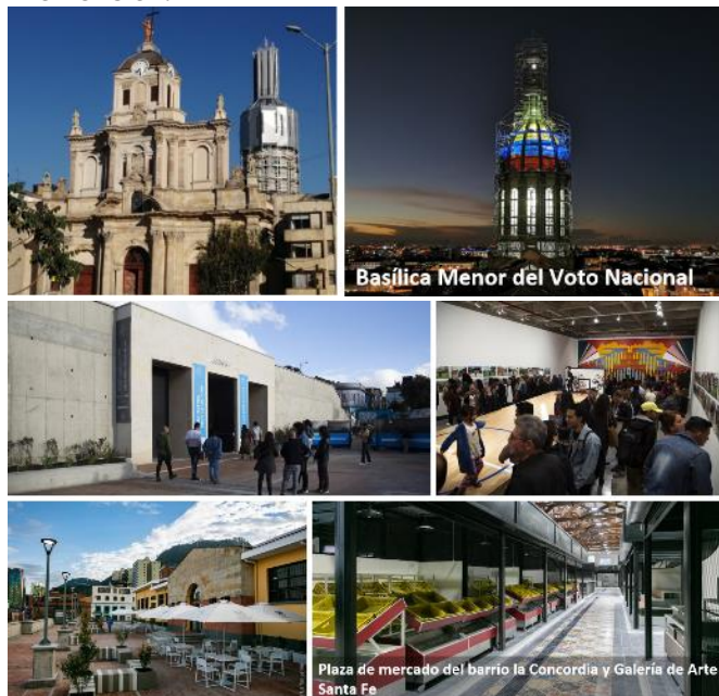
Imagen 12. Bienes Inmuebles en proceso de intervención.
