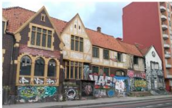
Fachada principal del inmueble 3 y sus alrededores. Fuente: SDP
