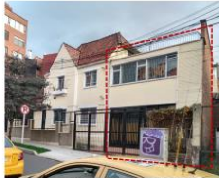
Fachada principal del inmueble 5 y localización. Fuente: IDPC
