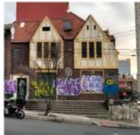
Fachada principal y lateral. Fuente: Archivo IDPC
