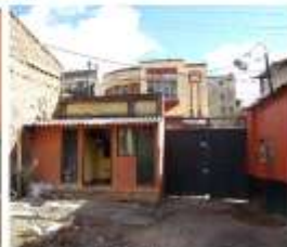
Vista inferior hacia el sur.
