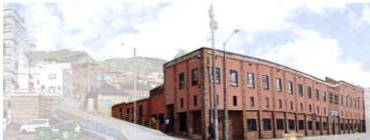
Imagen 1. Inmueble objeto de la solicitud. Fuente: Visita técnica IDPC, 2019.
