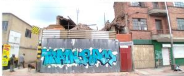
Estado actual de la fachada 2021. Fuente: Fuente: Visita IDPC mayo 2021.
