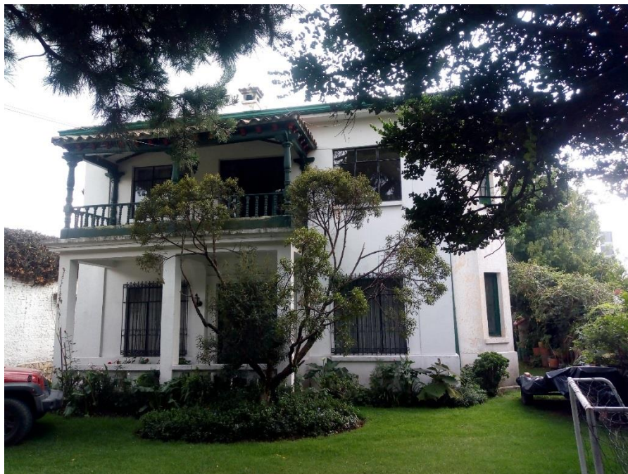
Imagen 1. Inmueble objeto de la solicitud. Fuente: Visita técnica IDPC, 2019.
