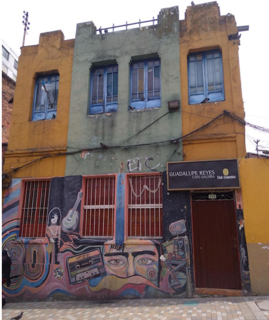
Fotografía 1 – Fachada del inmueble localizado en la Calle 12 D No. 3-84. Se evidencia estado avanzado de deterioro de la fachada con fracturas de pañete y desprendimientos parciales de pañete y pintura, que dejan a la vista material mampuesto de construcción de la fachada. (Fecha de toma de la imagen 18 de marzo de 2020).
