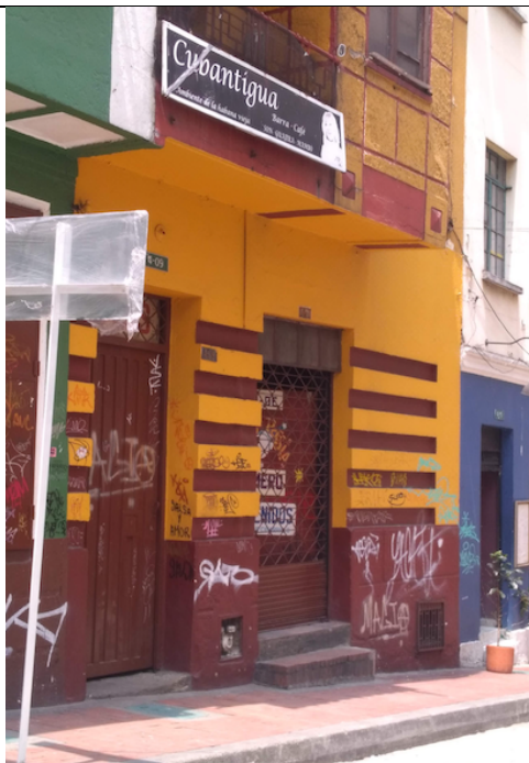
Fotografía 3 – Acercamiento a fachada del inmueble, sobre el frente de la Calle 12 D, en el costado izquierdo, se ubica el acceso peatonal al inmueble y sobre el costado derecho de la fachada, se ubica un local comercial. En el balcón del segundo nivel se exhibe un aviso del local comercial "Cuba antigua" (Fecha de toma de la imagen 18 de marzo de 2020).
