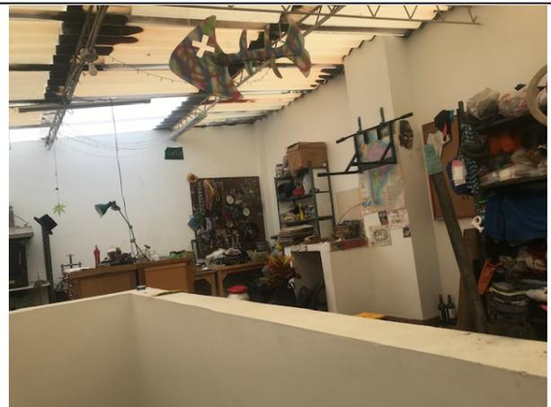
Fotografía del tercer piso, donde funciona el taller de artesanías. Algunas tejas de la cubierta están en mal estado por lo que se recomendó cambiarlas para evitar humedades.
