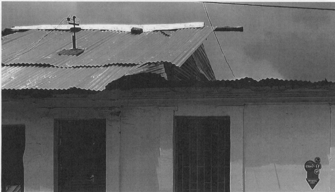
Sobrecubierta provisional, actualmente en teja metálica, se eliminó la cubierta en teja de barro Fotografía 2 – (Fecha de toma de la imagen 30 de julio del 2019)
