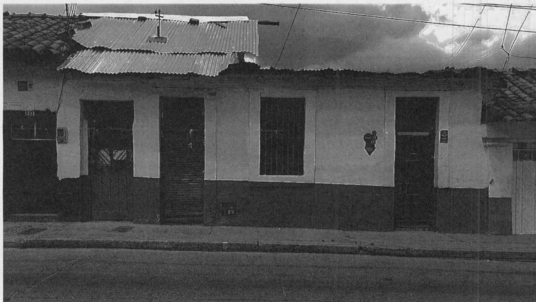
Fachada del inmueble localizado en la Calle 6B No. 8 – 85/87/89. Fotografía 1 – (Fecha de toma de la imagen 30 de julio del 2019).
