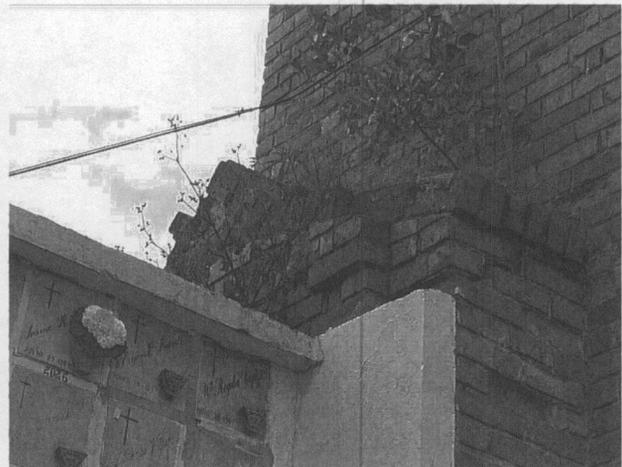
**Zona sur del mausoleo, se observa dislocación de muro en ladrillo.**
