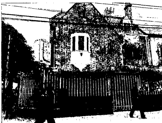
Fotografía 1 – Fachada por la calle 41 y evidencia de local comercial con uso de frutería (Fecha 17 octubre 2019).
