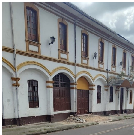
Imagen en donde se observa la intervención de la escalera de acceso al inmueble ubicado en la Calle 9 SUR No. 5A-07/11/25/35
