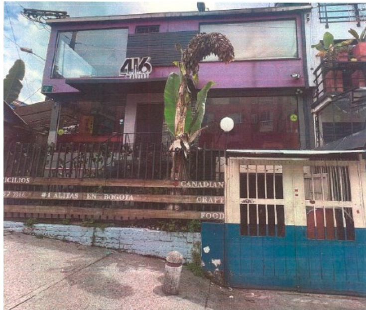
Fotografía del predio de la CL 65 4 07 aportada en la solicitud de control urbano. Fuente: radicado IDPC 20255110028832 del 2 de abril de 2025.
