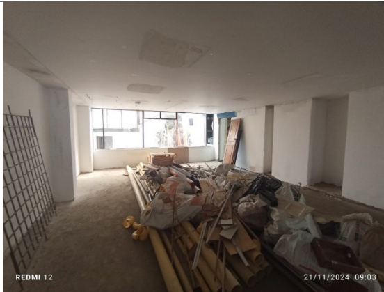
Fotografía 19 – estado actual del espacio del segundo piso en el cual se puede ver el acopio de escombros y la intervención en general. (Fecha de toma de la imagen 21/11/2024 ).
