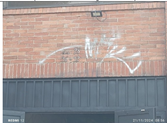
Fotografía 6 – fachada principal inmueble de la AK 28 36 32 en la cual se puede ver la nomenclatura del inmueble. (Fecha de toma de la imagen 21/11/2024 ).
