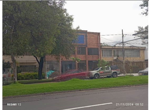
Fotografía 2 – fachada principal inmueble de la AK 28 36 32 sobre la avenida carrera 28. (Fecha de toma de la imagen 21/11/2024 ).
