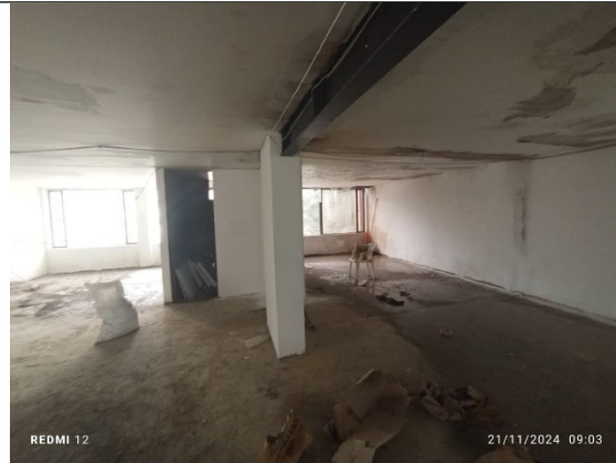
Fotografía 20 – estado actual del espacio del segundo piso en el cual se puede ver intervenciones de afinado de piso en la placa de entrepiso. (Fecha de toma de la imagen 21/11/2024 ).
