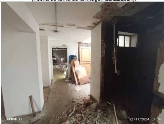
Fotografía 23 – intervenciones en el espacio de segundo piso contiguo a la escalera. Véase el retiro de algunos elementos de este espacio. (Fecha de toma de la imagen 21/11/2024 ).
