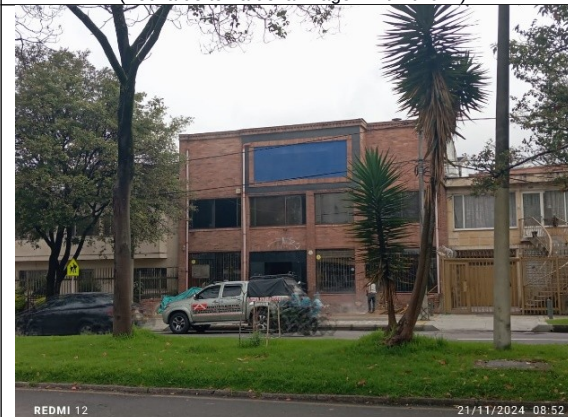
Fotografía 3 – fachada principal inmueble de la AK 28 36 32 sobre la avenida carrera 28. (Fecha de toma de la imagen 21/11/2024 ).
