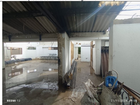
Fotografía 28 – espacio del tercer piso en el cual se evidencia una cubierta en eternit con estructura en cercha metálica. (Fecha de toma de la imagen 21/11/2024).
