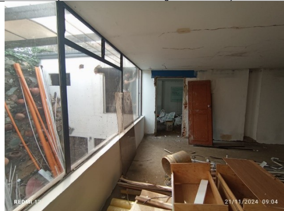
Fotografía 22 – estado actual del espacio del segundo piso frente al aislamiento posterior, en el cual se pueden ver el avance de las intervenciones. (Fecha de toma de la imagen 21/11/2024 ).
