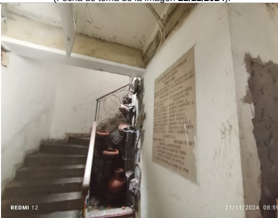
Fotografía 11 – circulación vertical (escalera) que comunica el primer y segundo piso.
