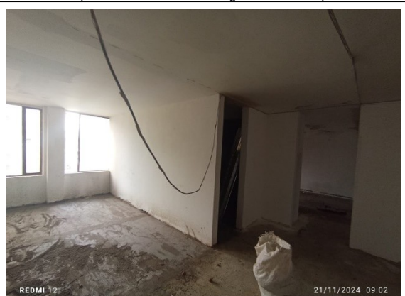
Fotografía 18 – estado actual del espacio del segundo piso en el cual se puede ver el avance de obra en general. (Fecha de toma de la imagen 21/11/2024 ).
