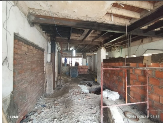
Fotografía 8 – estado actual del espacio de acceso del primer piso con obras en muros y placa de contrapiso, y la instalación de la estructura metálica en la placa de segundo piso.
