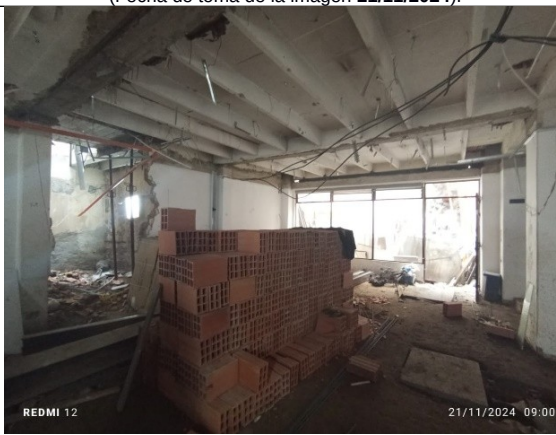
Fotografía 12 – acopio de bloques en uno de los espacios de primer piso localizado en la parte posterior del inmueble.
