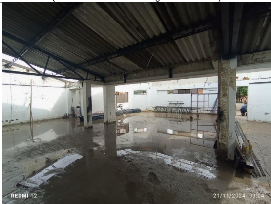
Fotografía 27 – espacio del tercer piso en el cual se evidencia una cubierta en eternit con estructura en cercha metálica. (Fecha de toma de la imagen 21/11/2024).
