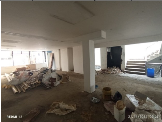
Fotografía 21 – estado actual del espacio del segundo piso en el cual se puede ver el acopio de escombros y la intervención en general. (Fecha de toma de la imagen 21/11/2024 ).
