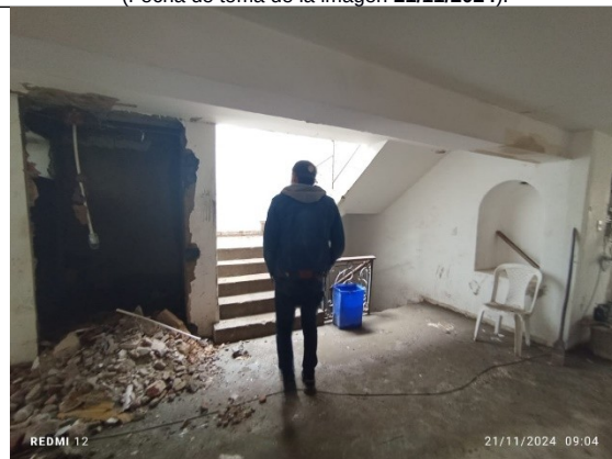
Fotografía 24 – circulación vertical (escalera) que comunica el segundo y tercer piso. Se pueden observar escombros que pudieron ser causados por la demolición de muros. (Fecha de toma de la imagen 21/11/2024 ).
