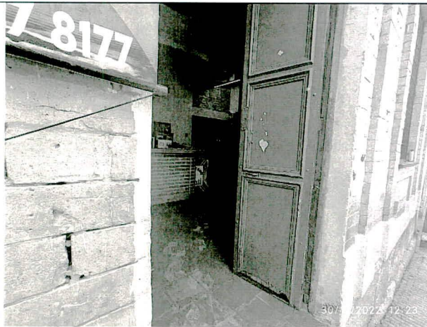
Fotografía 9 – Al fondo, obras que se adelantan en el espacio que se comunica con el acceso con nomenclatura 5-32 sobre la calle octava. (Fecha de toma de la imagen 30 de noviembre 2022).
