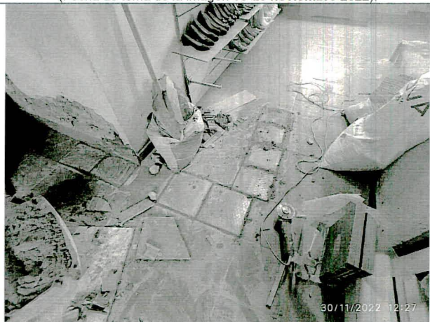
Fotografía 12 – Intervenciones en acabado de piso en el baldosín y material en obra. (Fecha de toma de la imagen 30 de noviembre 2022).
