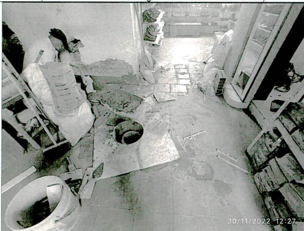
Fotografía 11 – Intervenciones que se adelantan en el inmueble; véase personal de obra trabajando. (Fecha de toma de la imagen 30 de noviembre 2022).
