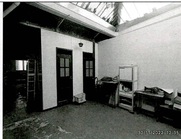
Fotografía 16 – Estado actual del patio cubierto céntrico del inmueble de la CL 8 5 33 (Fecha de toma de la imagen 30 de noviembre 2022).
