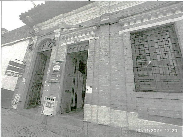
Fotografía 5 – Accesos con nomenclatura 5-31 y 5-32 sobre la fachada principal inmueble de la CL 8 5 33 sobre la calle octava. (Fecha de toma de la imagen 30 de noviembre 2022).
