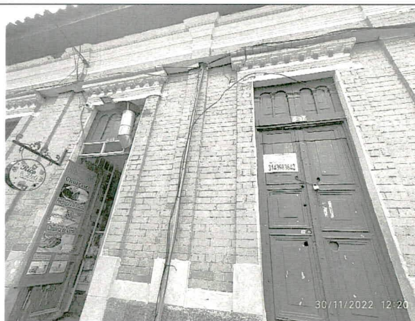
Fotografía 4 – Accesos con nomenclatura 5-35 y 5-37 sobre la fachada principal inmueble de la CL 8 5 33 sobre la calle octava. (Fecha de toma de la imagen 30 de noviembre 2022).
