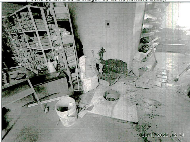
Fotografía 14 – Vista general del alcance de las obras ejecutadas en el espacio en intervención, véase mortero en pañete de muro. (Fecha de toma de la imagen 30 de noviembre 2022).
