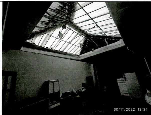
Fotografía 15 – Estado actual del patio cubierto céntrico del inmueble de la CL 8 5 33 (Fecha de toma de la imagen 30 de noviembre 2022).
