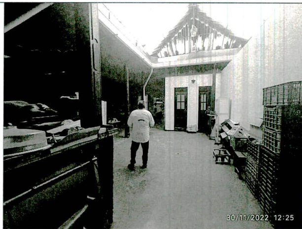
Fotografía 10 – Estado actual del patio cubierto céntrico del inmueble de la CL 8 5 33 (Fecha de toma de la imagen 30 de noviembre 2022).
