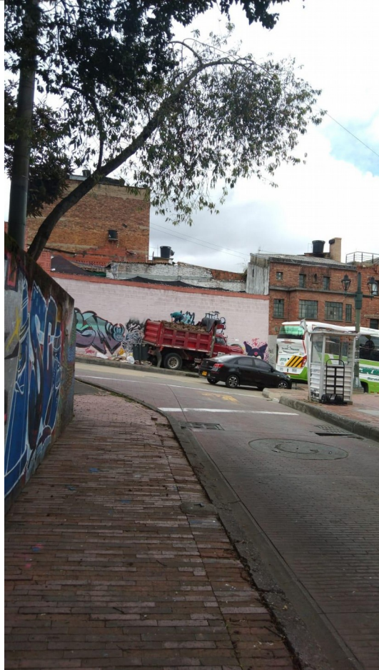
Fotografía 9 – Fachada principal inmueble de CL 12C 1 09 con volqueta y escombros. (Fecha de toma de la imagen 06/2023).
