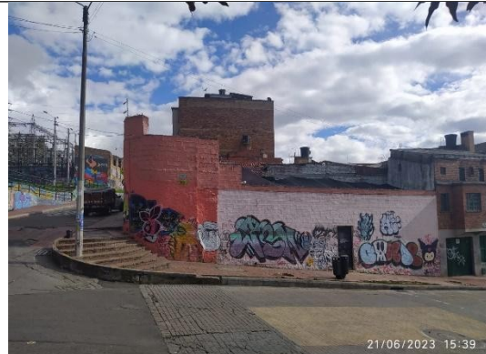
Fotografía 2 – Fachada principal inmueble de CL 12C 1 09 sobre la calle 12C. (Fecha de toma de la imagen 21/06/2023 ).
