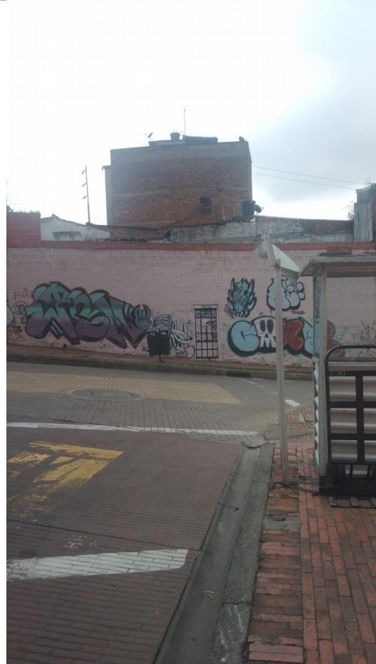
Fotografía 10 – Fachada principal inmueble de CL 12C 1 09 sobre la calle 12C. (Fecha de toma de la imagen 06/2023).
