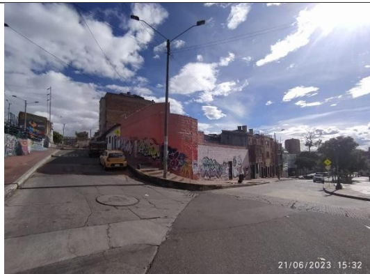
Fotografía 3 – Fachada principal inmueble de CL 12C 1 09 sobre la calle 12C. (Fecha de toma de la imagen 21/06/2023 ).
