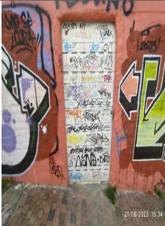
Fotografía 7 – Ingreso al inmueble de la CL 12C 1 09 sobre la carrera 1. (Fecha de toma de la imagen 21/06/2023 ).
