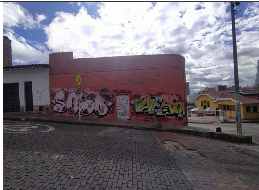
Fotografía 4 – Fachada principal inmueble de CL 12C 1 09 sobre la carrera 1. (Fecha de toma de la imagen 21/06/2023 ).
