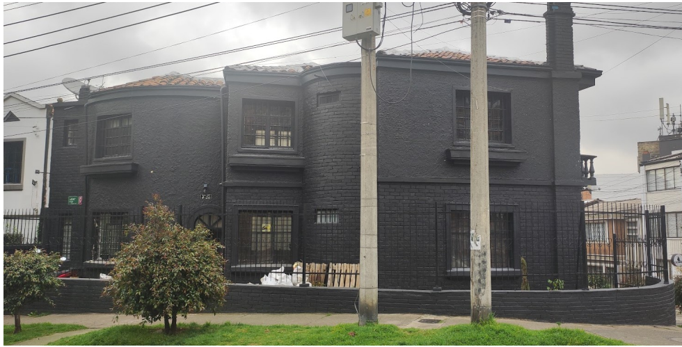
Fotografía 1. Se observa fachada por la calle del inmueble ubicado en la DG 55 4 33/37 y/o CL 54A 4 26. (Fecha de toma de la fotografía: 17 de mayo de 2023)
