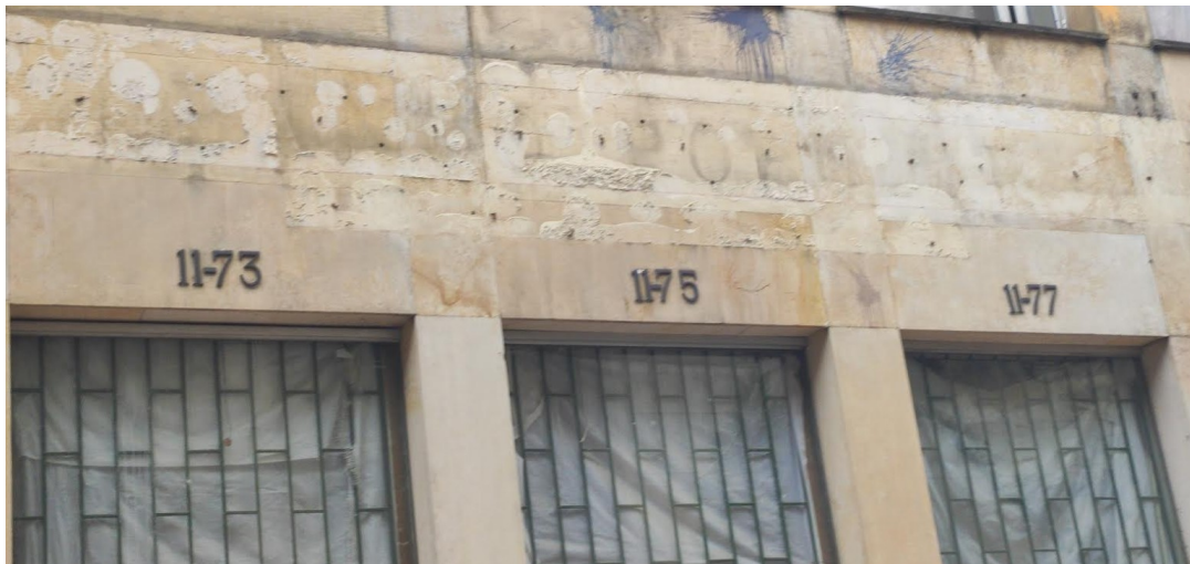
Fotografía 2. Se observa nomenclaturas del inmueble ubicado en la Carrera 8 No. 11-73/75/77. (Fecha de toma de la fotografía: 27 de abril de 2023)
