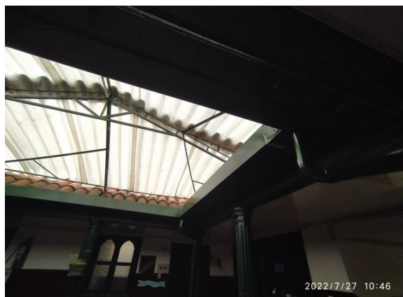
Fotografía 16 – Mantenimiento y reparación de canales y bajantes entorno a patio central. Inmueble No. 5: CL 9 4 40. (Fecha de toma de la imagen 27 de julio de 2022).
