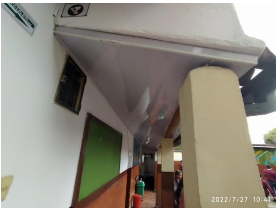
Fotografía 9 – Instalación de cielorraso en PVC blanco en pasillo exterior lateral. Inmuebles No. 4: CL 9 4 24 y No. 5: CL 9 4 40. (Fecha de toma de la imagen 27 de julio de 2022).
