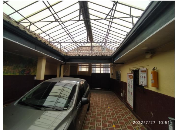
Fotografía 24 – Instalación de cielorraso en PVC blanco entorno a patio cubierto. Inmueble No. 1: CL 9 4 10. (Fecha de toma de la imagen 27 de julio de 2022).
