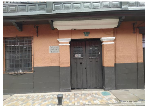
Fotografía 4 – Ingreso principal al conjunto de predios que conforman el COLEGIO SANTÍSIMO ROSARIO en el inmueble No. 3: KR 4 9 37 (Fecha de toma de la imagen 27 de julio de 2022).
