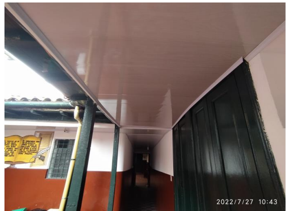
Fotografía 14 – Instalación de cielorraso en PVC blanco entorno a pasillos de patio central y pasillo central. Inmueble No. 5: CL 9 4 40. (Fecha de toma de la imagen 27 de julio de 2022).
