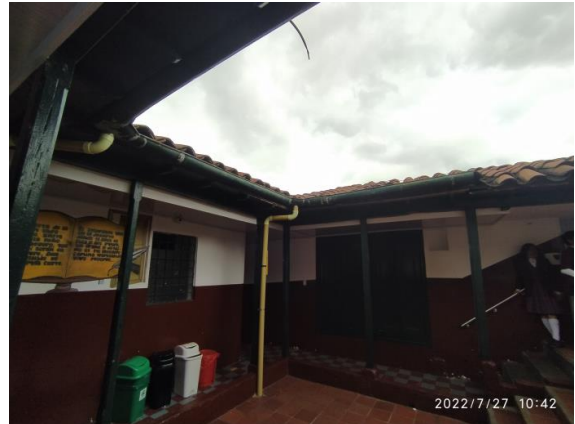
Fotografía 12 – Instalación de cielorraso en PVC blanco entorno a pasillos de patio central. Inmueble No. 5: CL 9 4 40. (Fecha de toma de la imagen 27 de julio de 2022).
