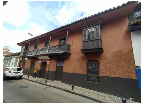
Fotografía 2 – Fachada principal inmueble No. 3: KR 4 9 37 sobre la carrera 4. (Fecha de toma de la imagen 27 de julio de 2022).
