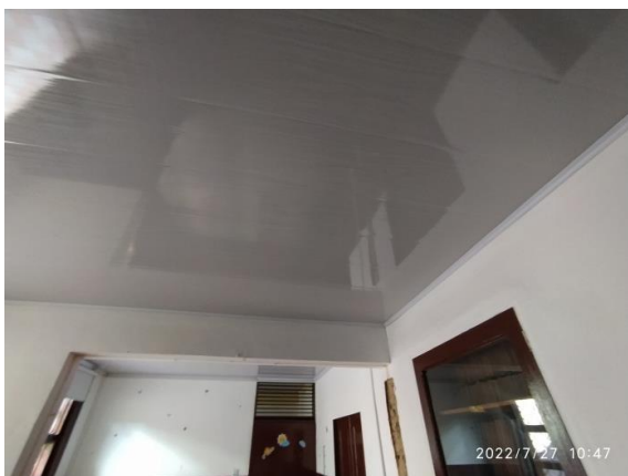
Fotografía 17 – Instalación de cielorraso en PVC blanco espacios de circulación internos. Inmueble No. 4: CL 9 4 24. (Fecha de toma de la imagen 27 de julio de 2022).
