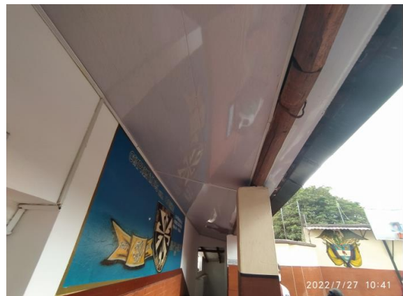
Fotografía 10 – Instalación de cielorraso en PVC blanco en pasillo exterior lateral. Inmuebles No. 5: CL 9 4 40 y No. 6: CL 9 4 48. (Fecha de toma de la imagen 27 de julio de 2022).
