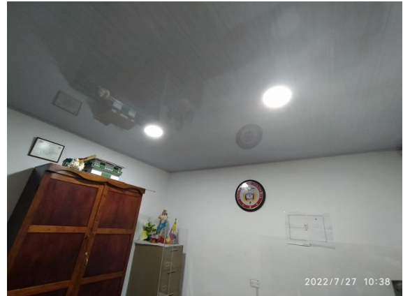
Fotografía 6 – Instalación de cielorraso en PVC blanco en una oficina. Inmueble No. 3: KR 4 9 37 (Fecha de toma de la imagen 27 de julio de 2022).
