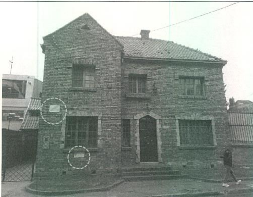
Fotografía 1 – Fachada principal del inmueble de la TV 16A 46 16, se evidencia la valla informativa de las reparaciones locativas autorizadas por el IDPC y también el sello impuesto por la SCRD el pasado 11 de octubre de 2022 (Fecha de toma de la imagen 23/08/2022).
