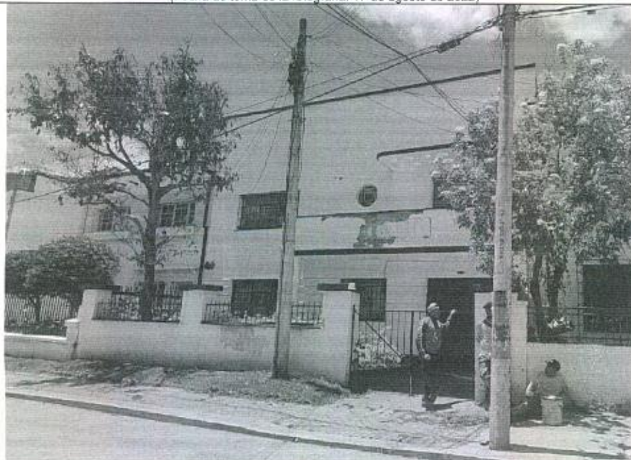
Fotografía 5 Se observa tres trabajadores frente al predio ubicado en la Carrera 16 A No. 30 – 78 . (Fecha de toma de la fotografía: 17 de agosto de 2022)
