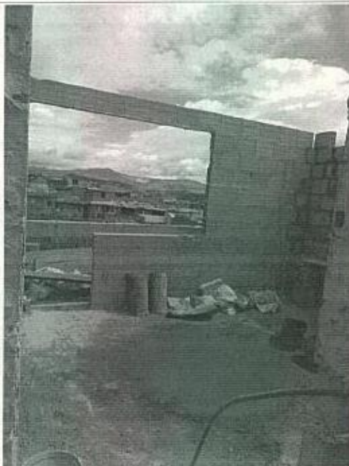
Fotografía 34 y 35 – En la parte frontal del predio, se evidencia la construcción de un nivel adicional a la altura original del inmueble, con muros en mampostería y placa fácil en el entre piso. (Fecha de toma de la imagen 18/07/2022).
