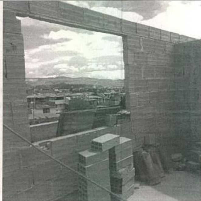
Fotografía 34 y 35 – En la parte frontal del predio, se evidencia la construcción de un nivel adicional a la altura original del inmueble, con muros en mampostería y placa fácil en el entre piso. (Fecha de toma de la imagen 18/07/2022).
