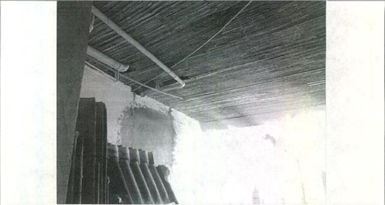
Fotografía 12 – En el segundo nivel de la parte frontal del edificio, se evidencia el retiro de acabados de cielorraso, así como la redistribución de redes hidrosanitarias y eléctricas en todo el nivel. También se evidencia el tapiado de vanos de comunicación original entre los espacios interiores
