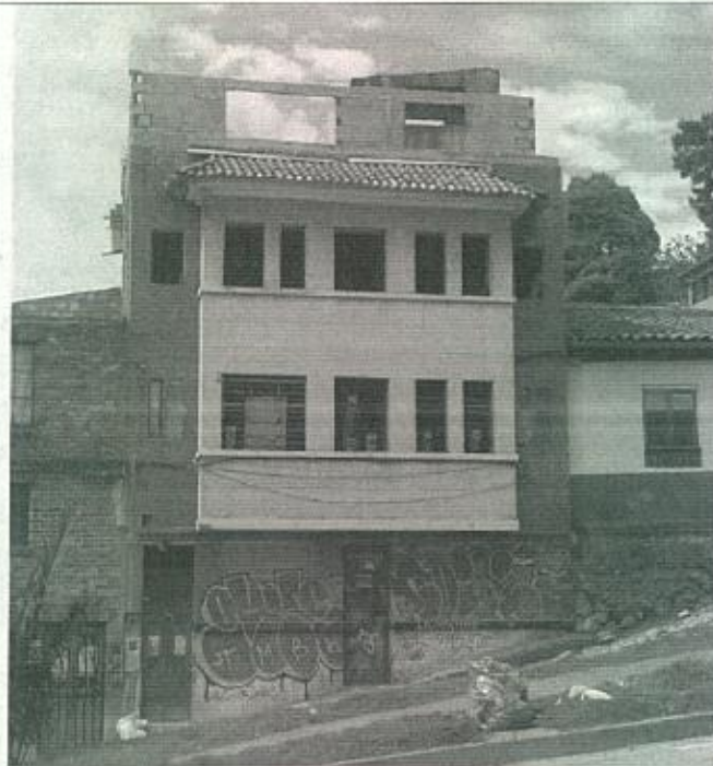
Fotografías 1 – Fachada principal del inmueble, sobre la Calle 7, se evidencia la construcción reciente del cuarto nivel en la parte superior del predio, el cual dista de las condiciones originales del inmueble (Fecha de toma de la imagen 18/07/2022).
