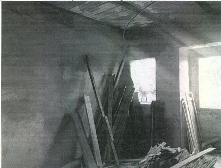
Fotografía 26 – En los espacios interiores del tercer nivel de la parte frontal del edificio se evidencia retiro de acabados de cielorraso, pisos en madera. Resane y alisado de vanos, y tapiado de vanos de comunicación interior entre espacios; así como modificación de la cubierta original, que según aerofotografías era en teja de barro y con desnivel sobre la fachada, en la actualidad es una placa de entrepiso plana en placa fácil. (Fecha de toma de la imagen 18/07/2022).
