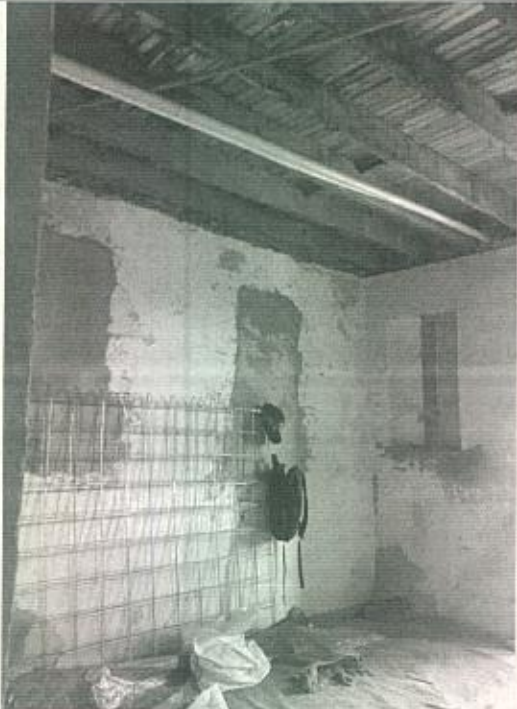
Fotografía 13 y 14 – En el segundo nivel de la parte frontal del edificio, se evidencia el retro de acabados de cielorraso, así como la redistribución de redes hidrosanitarias y eléctricas en todo el nivel. También se evidencia el tapiado de vanos de comunicación original entre los espacios interiores. (Fecha de toma de la imagen 18/07/2022).
