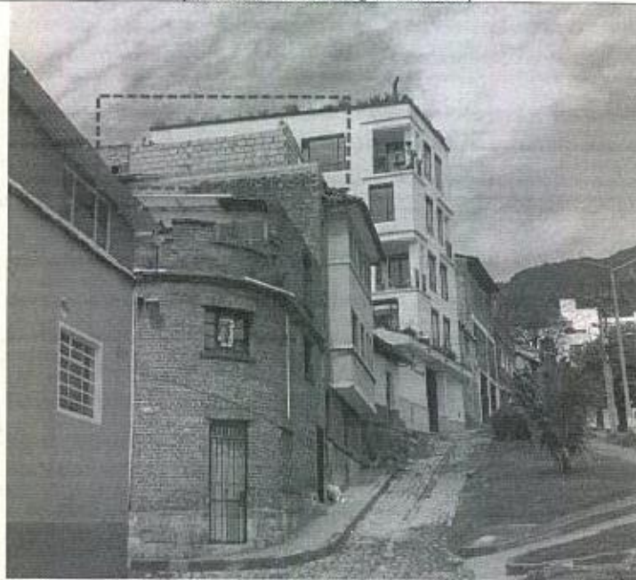
Fotografía 38 – Desde el exterior, por la calle 8 (empedrada) se observa la afectación que a nivel de altura genera la adición de niveles adicionales en el inmueble, respecto a los que se ubican a su alrededor. (Fecha de toma de la imagen 18/07/2022).
