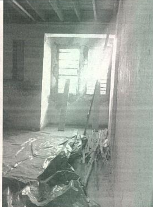
Fotografía 13 y 14 – En el segundo nivel de la parte frontal del edificio, se evidencia el retro de acabados de cielorraso, así como la redistribución de redes hidrosanitarias y eléctricas en todo el nivel. También se evidencia el tapiado de vanos de comunicación original entre los espacios interiores. (Fecha de toma de la imagen 18/07/2022).
