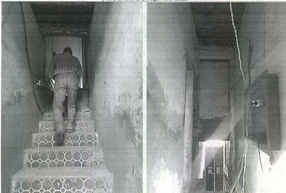
Fotografías 4 y 5 – Al ingresar por el acceso principal, se conduce a unas escaleras que dirigen al segundo nivel del cuerpo que se encuentra sobre la fachada, y al primer nivel de la parte posterior del inmueble, esto debido al desnivel del terreno en el que se ubica (Fecha de toma de la imagen 18/07/2022).
