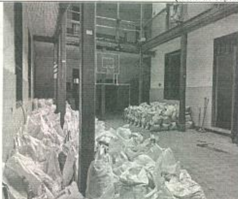
Imagen 8 y 9- Material de adobe del muro medianero que colapso, contenido en lonas en el patio del predio afectado Carrera 4 10-32/38, para ser reconstruido, tan pronto sea resuelto el problema del mal encauce de la aguas lluvias aparentemente ocasionado por el predio colindante. Carrera 4 10-32/38 (fecha de captura de la imagen: 13 de junio 2022)
