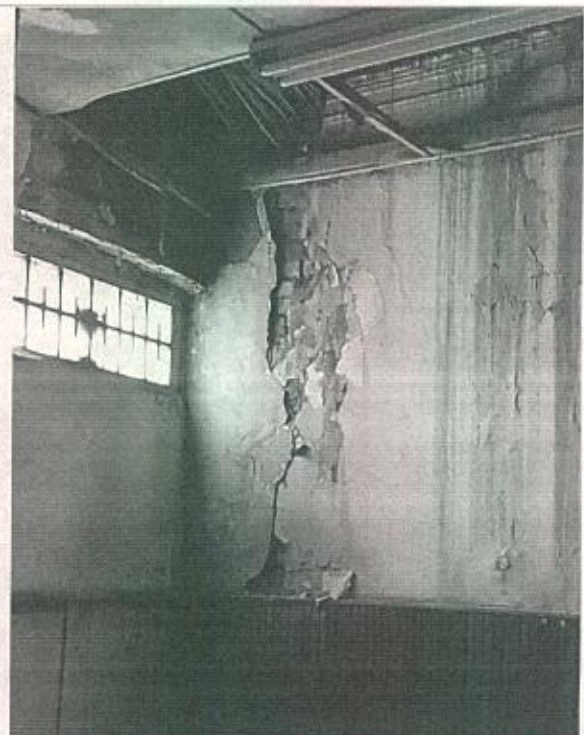
Imagen 2 y 3. Muro del salón, costado noroccidental del inmueble Carrera 4 10-32/38 que presenta afectación, así como el cielo raso y el entre piso aparentemente por escorrentía de agua lluvia mal encausada por parte del predio colindante Carrera 4 10-40. (fecha de captura de la imagen: 13 de junio de 2022)
