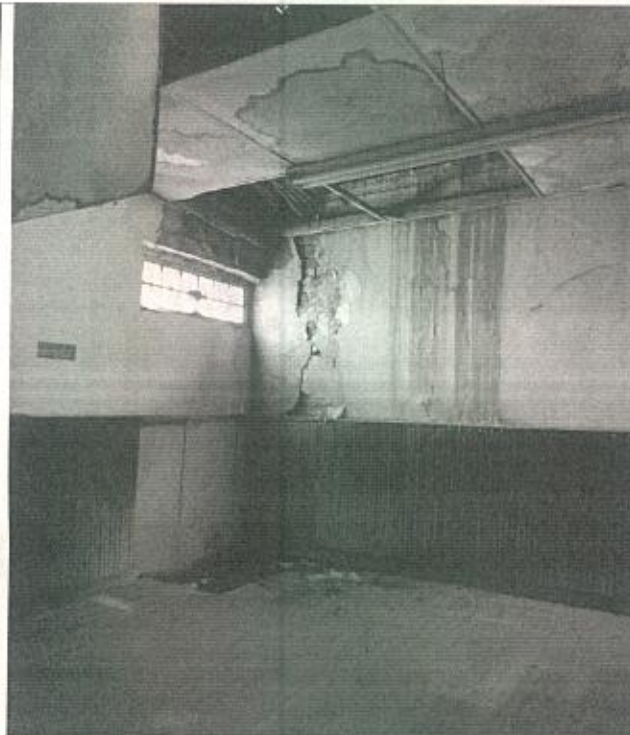
Imagen 2 y 3. Muro del salón, costado noroccidental del inmueble Carrera 4 10-32/38 que presenta afectación, así como el cielo raso y el entre piso aparentemente por escorrentía de agua lluvia mal encausada por parte del predio colindante Carrera 4 10-40. (fecha de captura de la imagen: 13 de junio de 2022)
