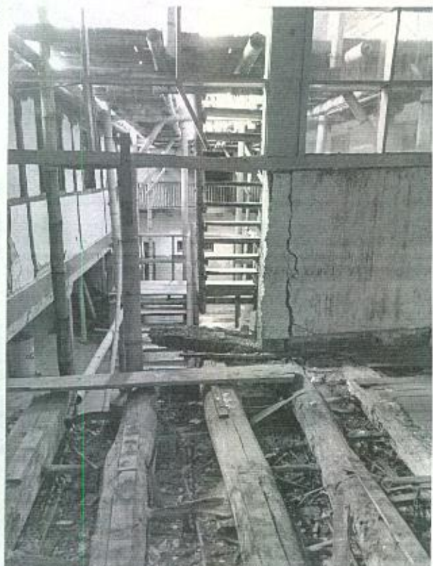
Imagen 15. Detalle del muro estructural de adobe en total deterioro a causa aparentemente de la escorrentía de las aguas lluvias. Imagen 15. El entrepiso de la segunda planta, perdió todo el acabado de piso de madera y parte del muro de ante pecho, así como el marco de la ventana y los vidrios a casusa aparentemente de la humedad proveniente de la escorrentía de aguas lluvias del colindante.
