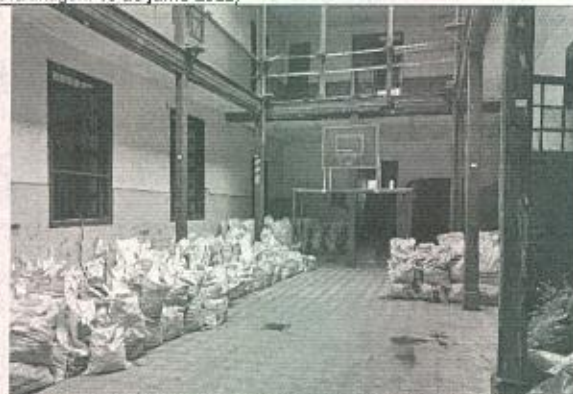
Imagen 8 y 9- Material de adobe del muro medianero que colapso, contenido en lonas en el patio del predio afectado Carrera 4 10-32/38, para ser reconstruido, tan pronto sea resuelto el problema del mal encauce de la aguas lluvias aparentemente ocasionado por el predio colindante. Carrera 4 10-32/38 (fecha de captura de la imagen: 13 de junio 2022)
