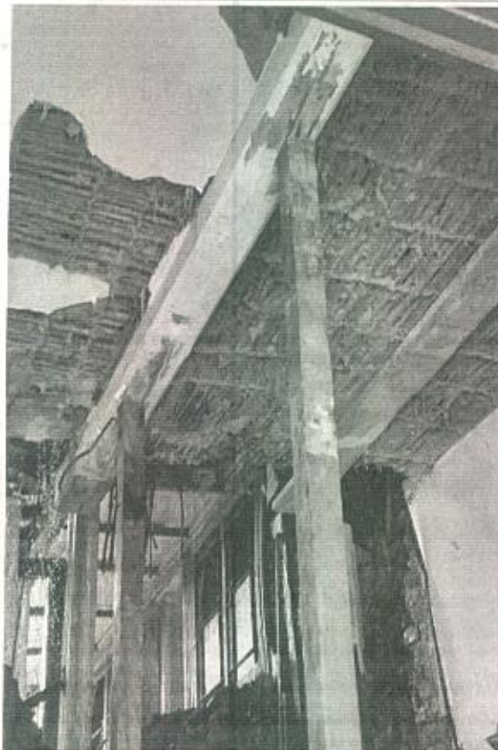
Imagen 7 (Izquierda). Apuntalamiento con viguetas y parales de madera para detener la caída del entrepiso del segundo nivel Carrera 4 10-32/38 Ocasionada al parecer por mal encauce de agua lluvia del predio colindante.
