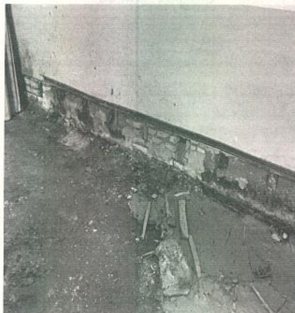
Imagen 4 y 5. Detalle del muro costado norte parte inferior del inmueble KR 4 10-32/38, donde se tuvo que retirar la estructura de madera de sobre piso y el piso en madera por el mal estado y humedad (fecha de captura de la imagen: 13 de junio 2022)
