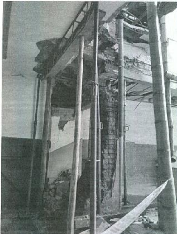
Imagen 15. Detalle del muro estructural de adobe en total deterioro a causa aparentemente de la escorrentía de las aguas lluvias. Imagen 15. El entrepiso de la segunda planta, perdió todo el acabado de piso de madera y parte del muro de ante pecho, así como el marco de la ventana y los vidrios a casusa aparentemente de la humedad proveniente de la escorrentía de aguas lluvias del colindante.
