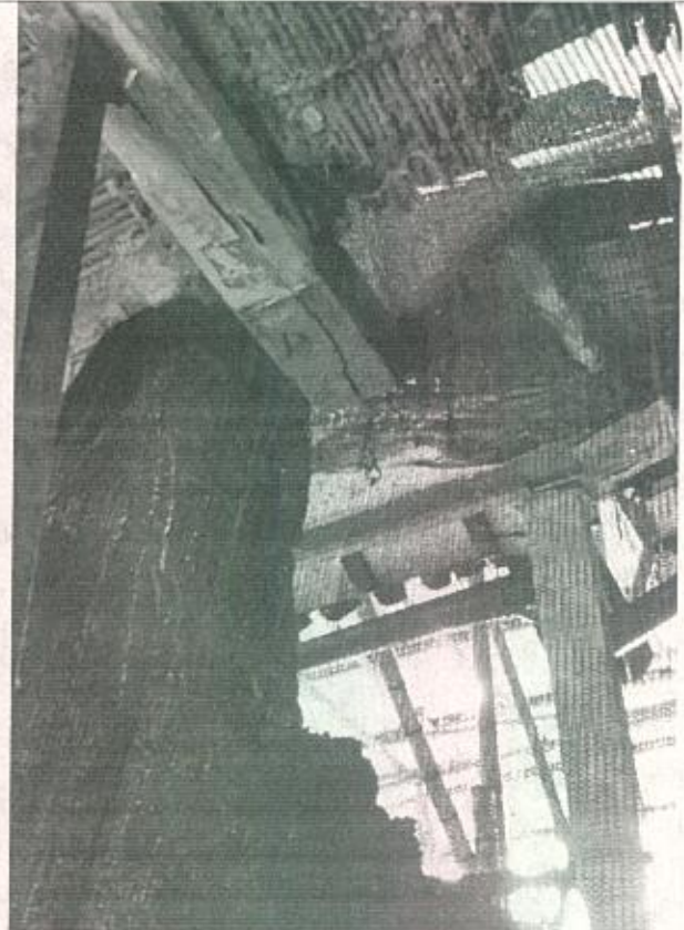
Imagen 7 (Izquierda). Apuntalamiento con viguetas y parales de madera para detener la caída del entrepiso del segundo nivel Carrera 4 10-32/38 Ocasionada al parecer por mal encauce de agua lluvia del predio colindante.
