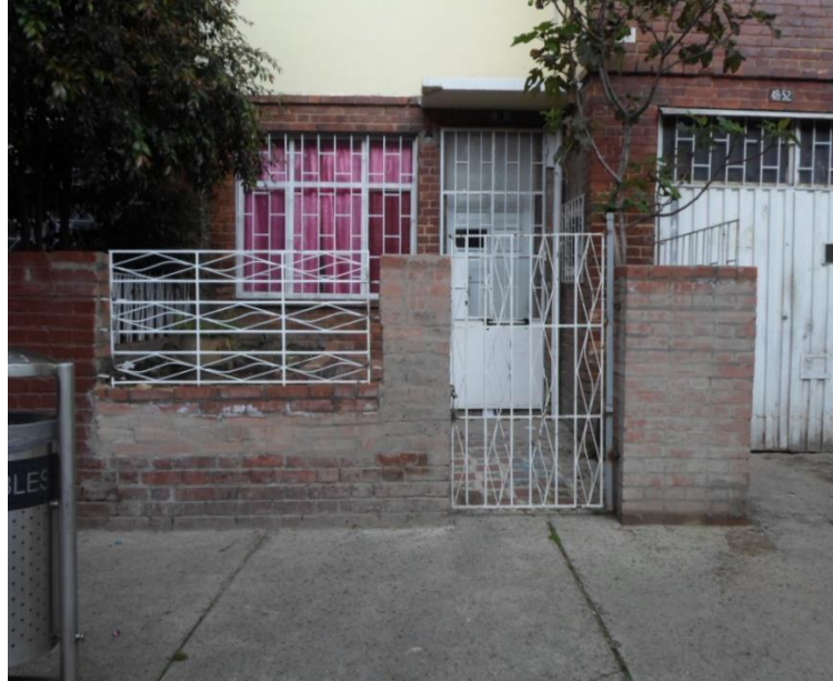
Foto 6- KR 16 A 48-56 imagen del cerramiento del muro del antejardín en ladrillo y reja metálica (fecha de captura de la imagen: 11-02-2022)
